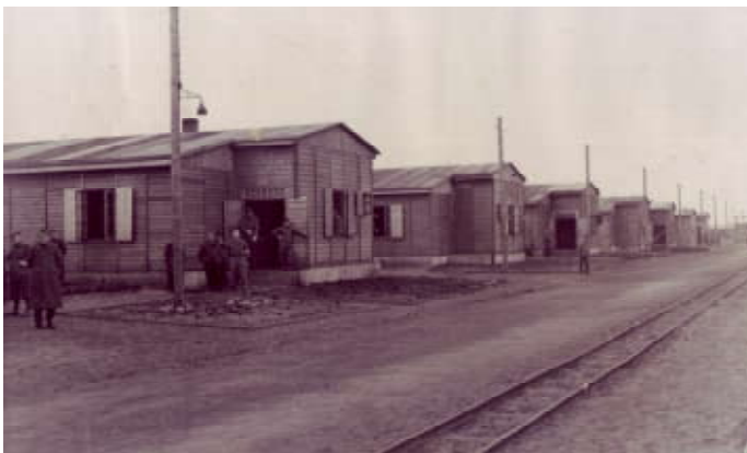
Baracken entlang der 700 Meter langen Lagerstraße und der Lorenbahnstrecke. Foto: Bestand Fritz Brandt, undatiert
