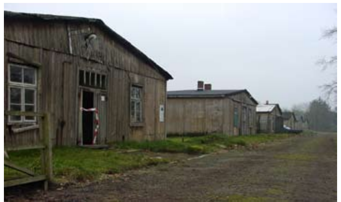
Der Zustand heute: erhaltene Baracken nach Sicherung der Bausubstanz.
