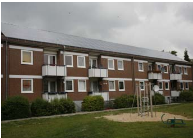
Zahlreiche Fotovoltaikanlagen auf den Dächern speisen Solarstrom ins Netz ein.
