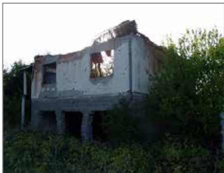
Vom Krieg zerstörtes Haus in Pristina
